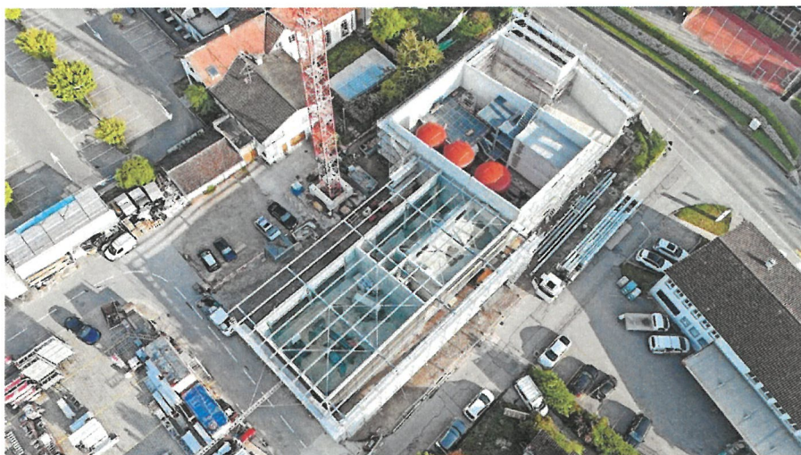
Die Energiezentrale Gruben des EVSH kann am 15. November von 9–16 Uhr besichtigt werden.
